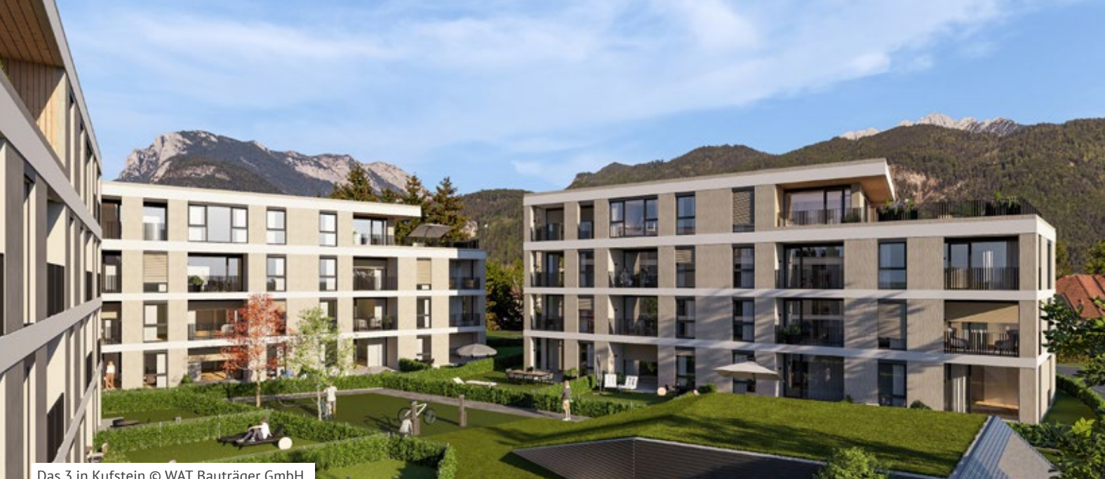
Das 3 in Kufstein © WAT Bauträger GmbH
